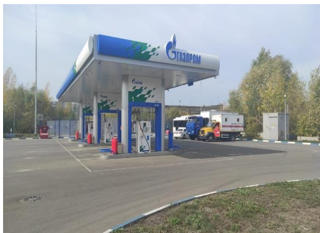
Автомобильная газонаполнительная компрессорная станция
